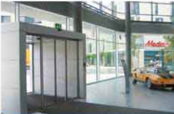
Slimdrive SL-BO, panik kaçış yolu idkaretinde, hareketli ve sabit kanatların, döner menşesi tertibat sayesinde, üzerine yüklenildiğinde dışa doğru açılmaları sağlar.
